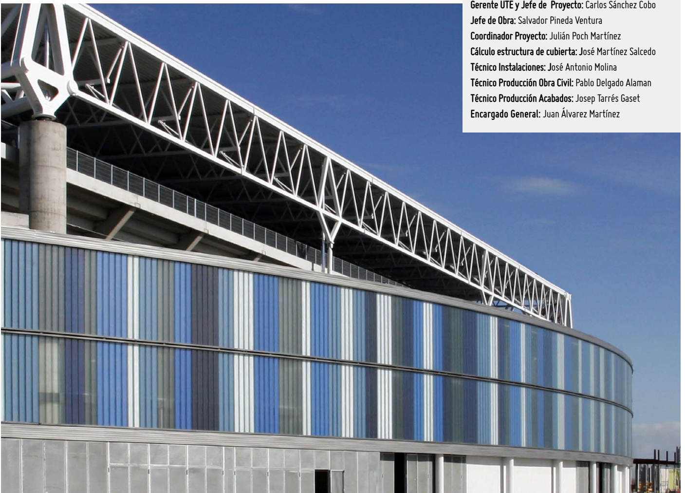
Fachada del estadio del Espanyol.
